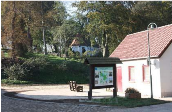
Ehemaliges Spritzenhaus, heute Mehrzweckgebäude
