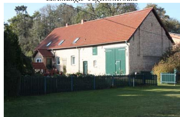
Ehemaliges Stallgebäude, heute Wohnhaus (rechter Flügel)
