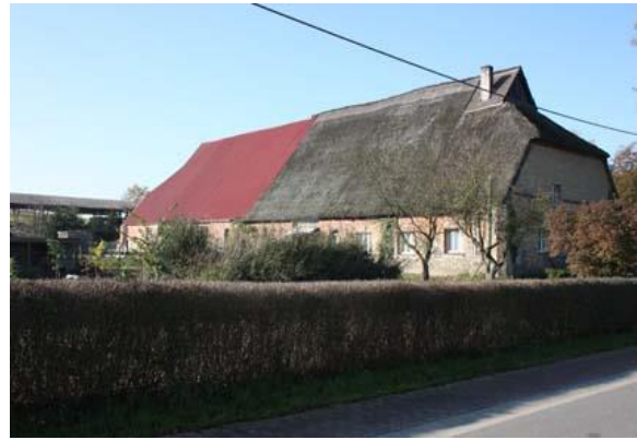
Ehemaliger Schafstall, seit 1945 Wohngebäude
